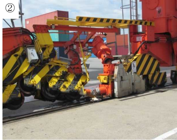
本件ガントリークレーン、S3号機 （走行装置損傷）
