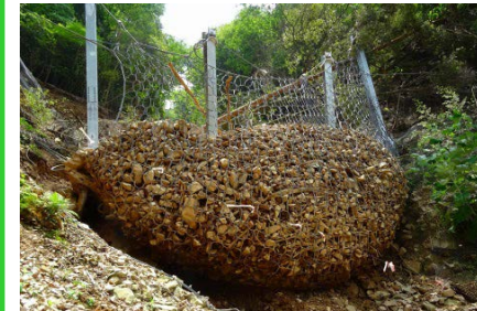
(参考)ワイヤーネットの施工箇所による土石・流木捕捉の例
